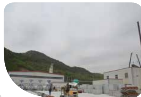
天水李子公司尾矿渣制砖项目
