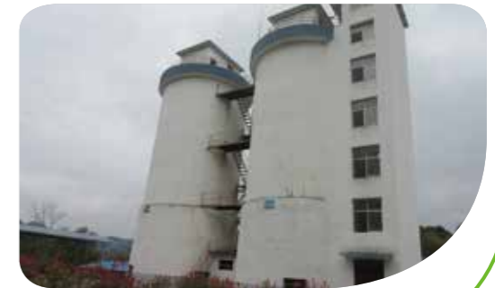
江西金山尾矿加压充填系统
