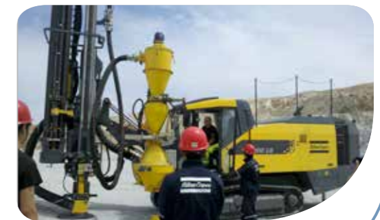
内蒙古矿业公司钻机施工现场
