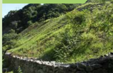
河南秦岭公司覆土植被治理渣坡
