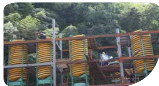
江西金山公司尾矿再选工程
