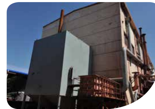
潼关冶炼公司金精炼布袋收尘系统
