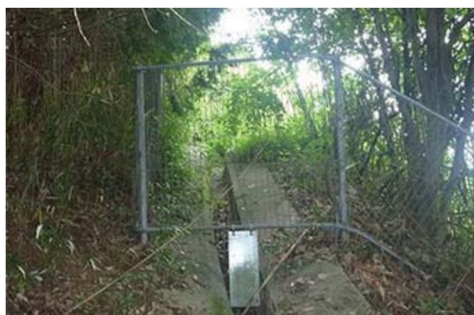
小中型動物侵入対策（排水溝の閉塞）
