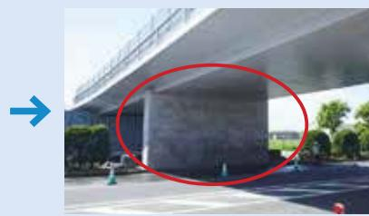
熊本 IC ランプ橋の様子(左:地震の影響で傾いた橋脚、右:補強後の橋脚)
