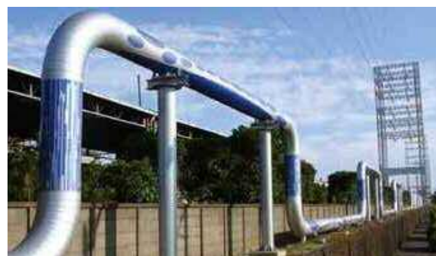
川崎スチームネット "Kawasaki Steam Net" 川崎火力発電所から蒸気を千鳥・夜光地区コンビナート内10社へ供給し、大幅な省エネとCO 2 削減に貢献しています
