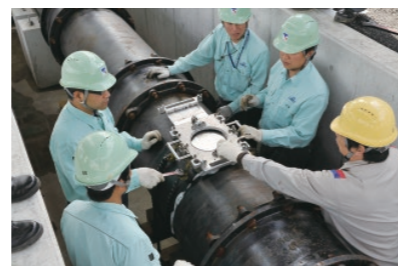
導管研修センター施設内での研修の様子
