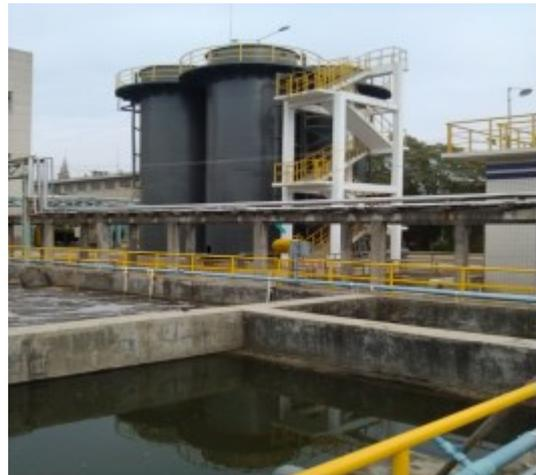
**废气治理方面：**公司各车间工艺废气处理设施运行正常，持续达标排放。生产过程中产生的废气采用水洗、碱洗二级吸收处理工艺，部分反应设施上也配备有尾气预处理装置，生产废气经预处理后再进入集中处理设施。部分干燥设备末端安装有废气冷凝回收装置，能够有效的对挥发性有机物进行冷凝回收。公司还对废水处理系统除油过滤池、预混池和厌氧池进行了加盖封闭，减少废气的逸散。
