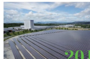
大福滋贺事业所的超大规模太阳能发电系统 在约5.2万平方米的土地上设置了1万7,752片太阳能电池板。最大发电能力达4,400kW，年发电量为430万度。
