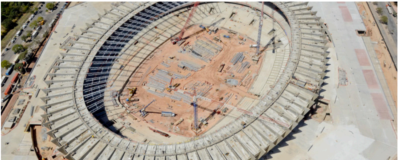
>> Visão aérea da obra de reforma e modernização do Mineirão (Sylvio Coutinho)
