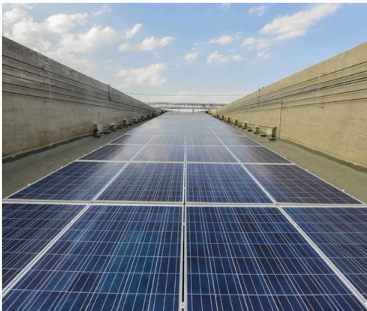
>> Placas da USF Mineirão, na cobertura do estádio. (Agência i7/Mineirão)
