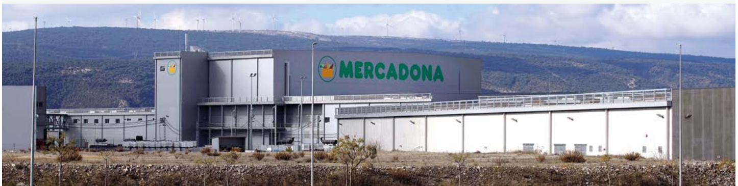
Bloque logístico de Vitoria-Gasteiz, Araba/Álava, en construcción.
