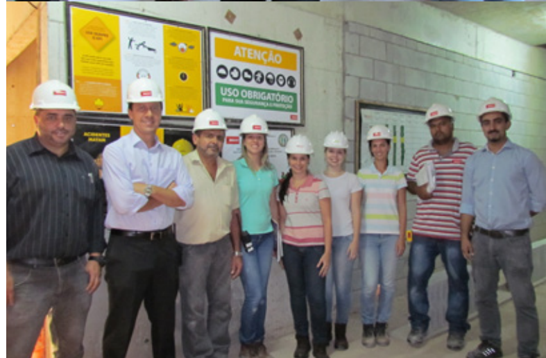
Equipe técnica durante a validação da unidade protótipo do Unique MBigucci, em construção na cidade de São Bernardo do Campo/SP
