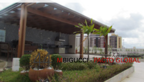
Nova sede da Atlética na cobertura do Boulevard Office
