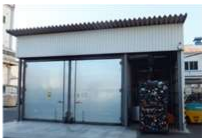
溶融固化施設
