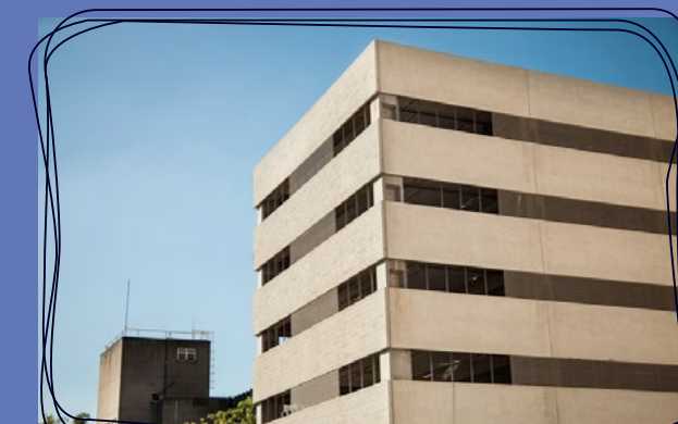
EDIFÍCIO GARAGEM DO TEMPLO DE SALOMÃO - SÃO PAULO/SP
