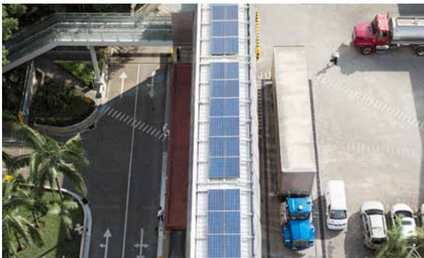
Paneles solares fotovoltaicos, Colcafé Medellín.
