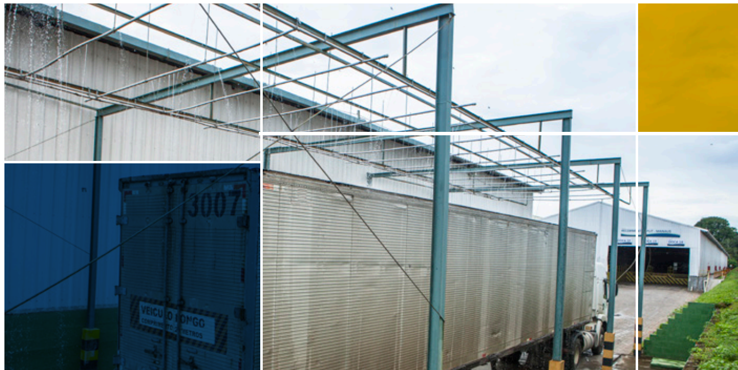
Agua de reúso de la lluvia en la Unidad de Manaus, un proceso que identifica si los vehículos que transportan los productos no tienen pérdidas.
