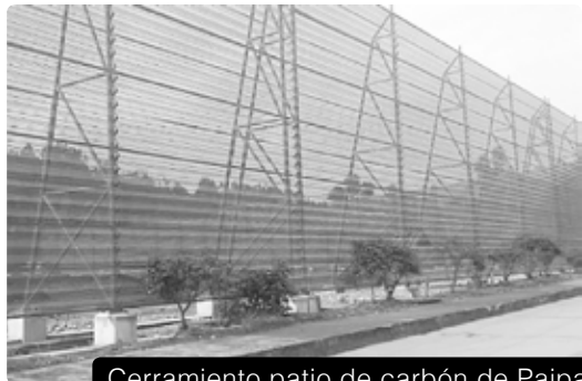
Cerramiento patio de carbón de Paipa
