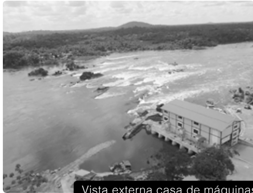
Vista externa casa de máquinas
