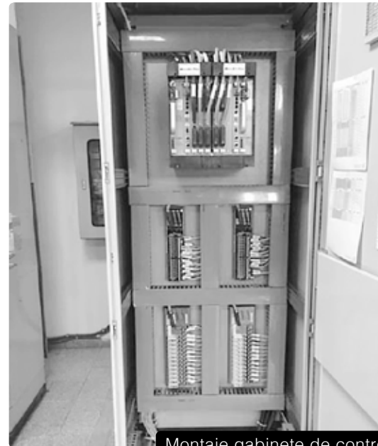
Montaje gabinete de control
