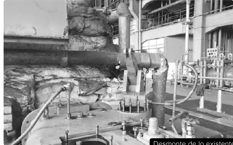
Desmonte de lo existente
