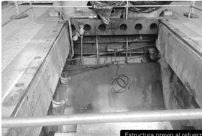
Estructura previo al refuerzo
