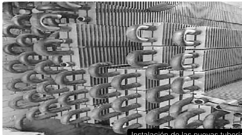
Instalación de las nuevas tuberías
