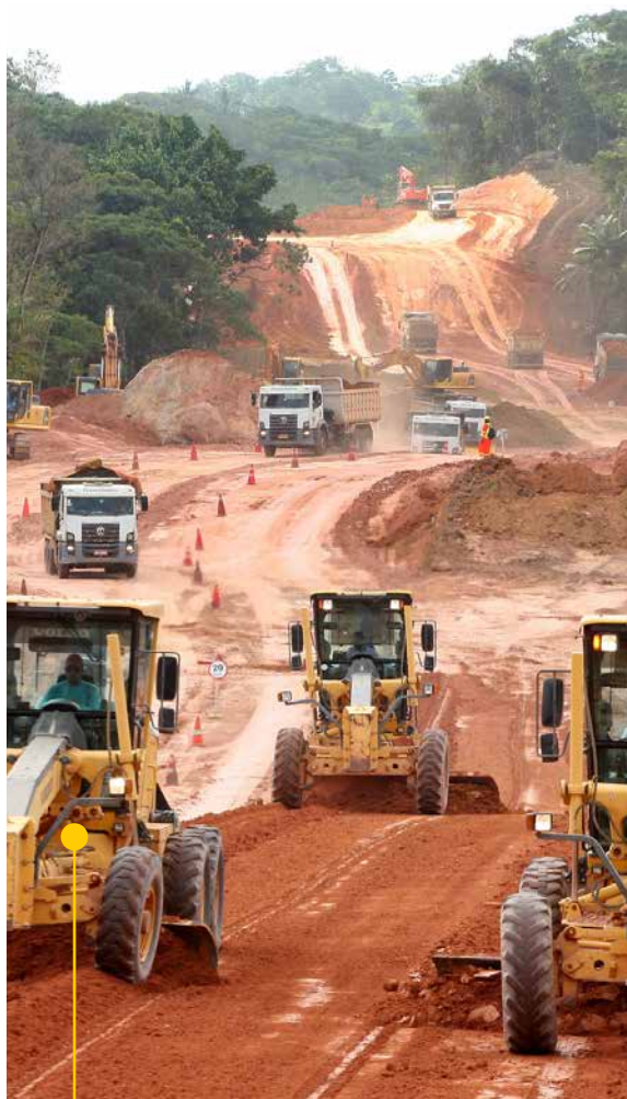
Obras do Contorno Camaçari—Lauro de Freitas
