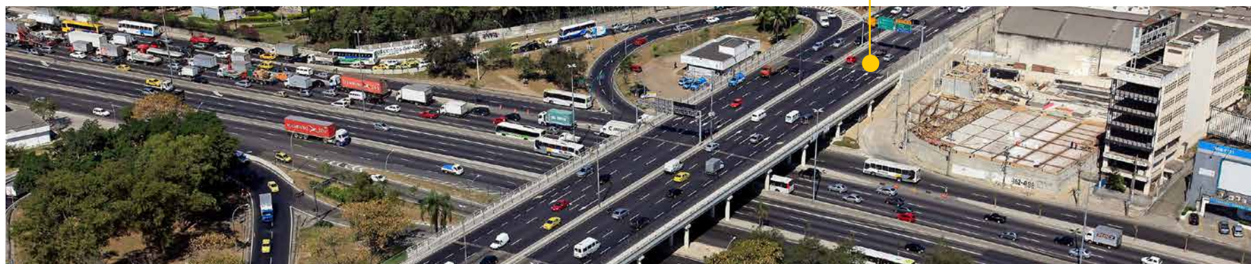
Trecho da Linha Amarela sobre a Avenida Brasil
