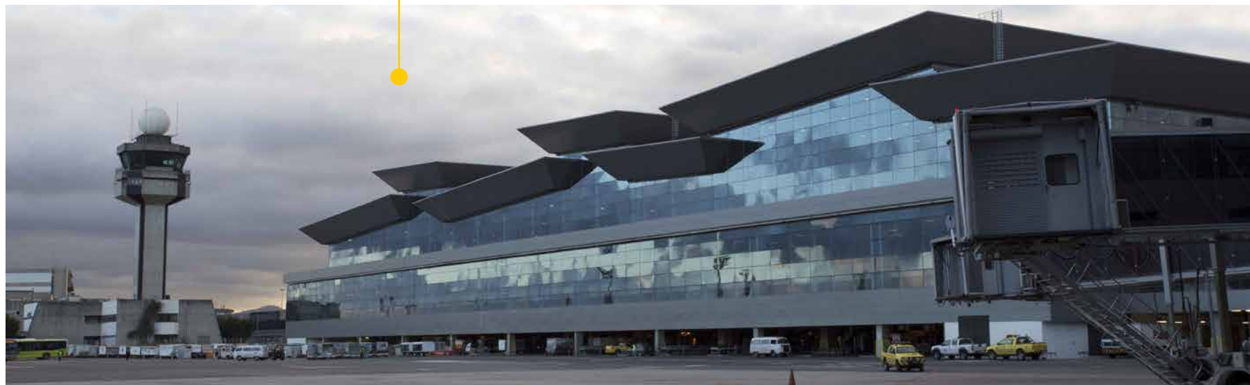
Visão externa do Terminal 3 de GRU Airport
