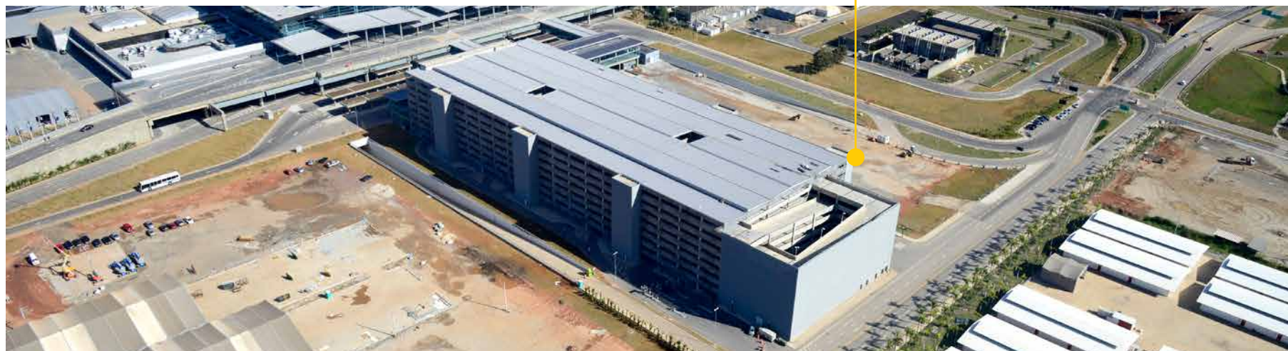
Edifício-Garagem de GRU Airport
