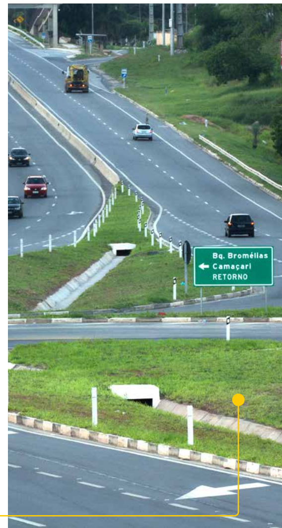
Trecho de rodovia administrada pela CBN - Concessionária Bahia Norte
