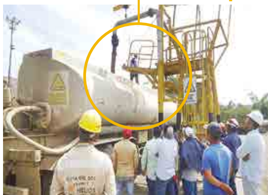
■ Instalación de línea de vida carga de vinaza, Área Compostaje
