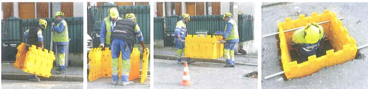
Un kit de blindage se compose de quatre plaques préassemblées, permettant de constituer un rectangle carré selon les choix effectués et de deux tubes de positionnement, permettant la manutention du blindage.
