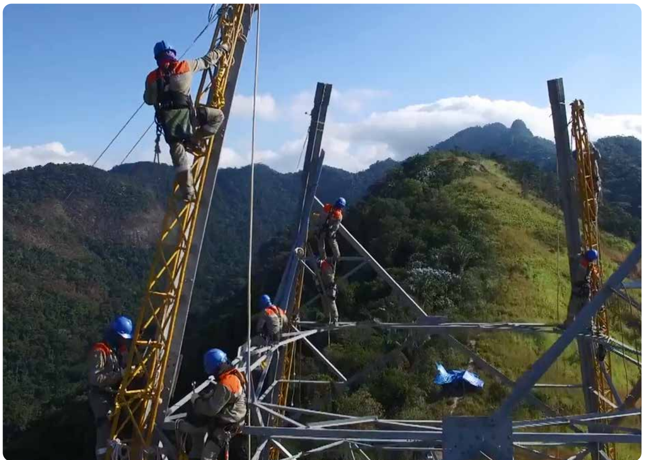
Construção da linha de transmissão Jacarepaguá/Curicica
