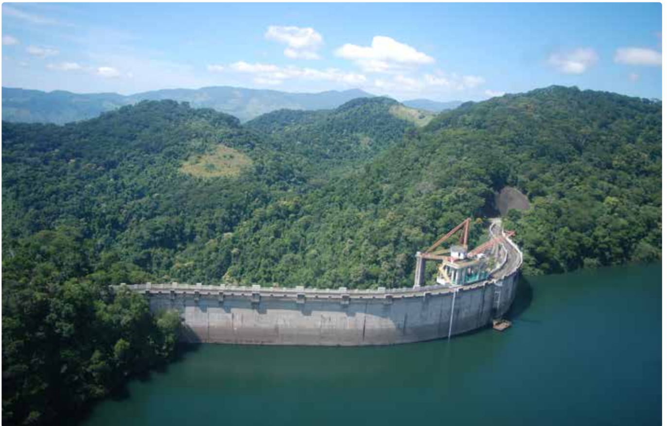
Reservatório de Lajes
