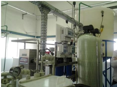
Na estação de tratamento dos efluentes, os resíduos sofrem degradação química e filtragem especial em duas estações. Na primeira estação são recuperadas 60% do teor de pureza da água. Os 40% restantes acontecem na segunda estação de tratamento. Após o tratamento, a água destilada é devolvida para os coletores pluviais da cidade.
