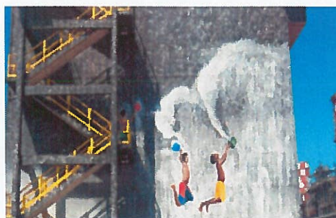
Novo projeto de grafite sobre as torres de resfriamento na usina.
