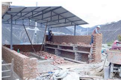
海拔 3900 米，施工中的青海玉树利民学校“ELITE 公共卫生间”。
