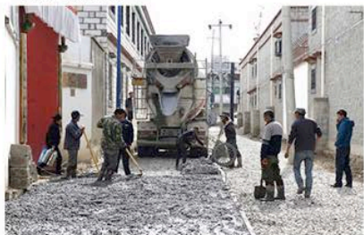
海拔 3600 米，施工中的拉萨彩泉福利特殊学校“ELITE 上学道路”。
