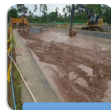
Estabilización de Cortes de Perforación
