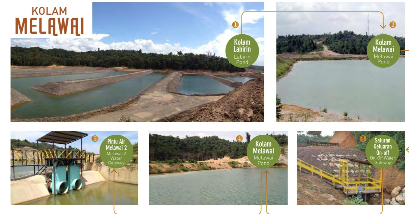
Konfigurasi Kolam Melawai Dilengkapi Dengan Saluran Keluaran On-Off yang Diletakkan di Level Lebih Rendah dari Spill Way Kolam
