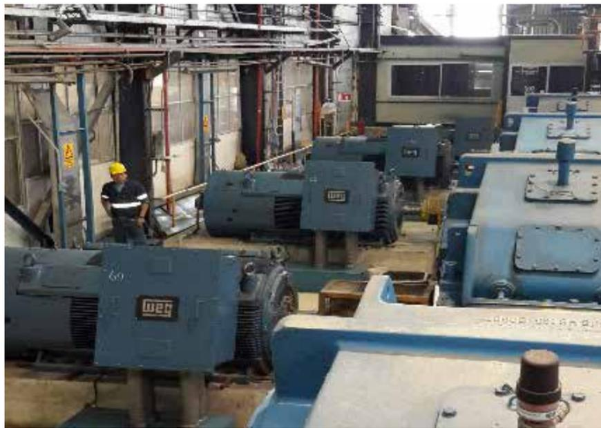
Modernización de equipos en área de molinos al sustituir turbinas de vapor a motores eléctricos de alta eficiencia para reducción de consumo de vapor y lubricantes.
