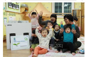
친환경 환기장치 설치
