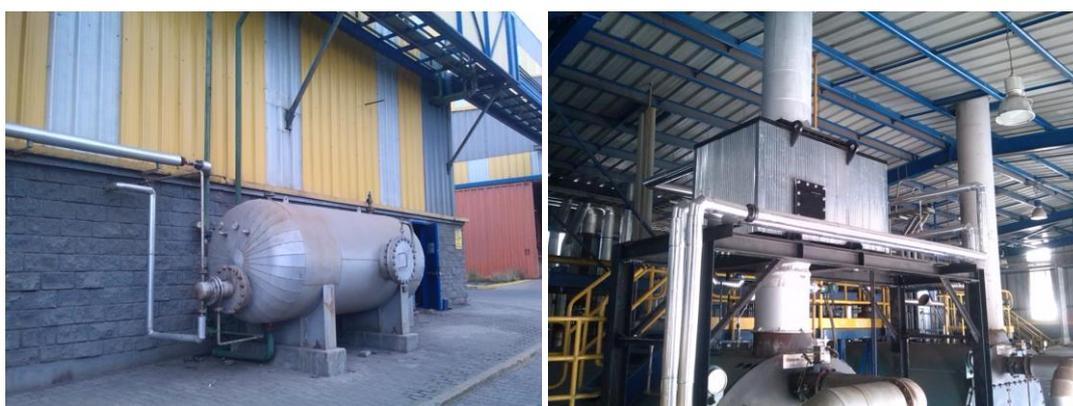
*Iniciativas de Eficiencia Energética implementadas en la central de vapor: recuperación de energía de aguas de purgas (izquierda) y desde gases de escape (derecha)*
