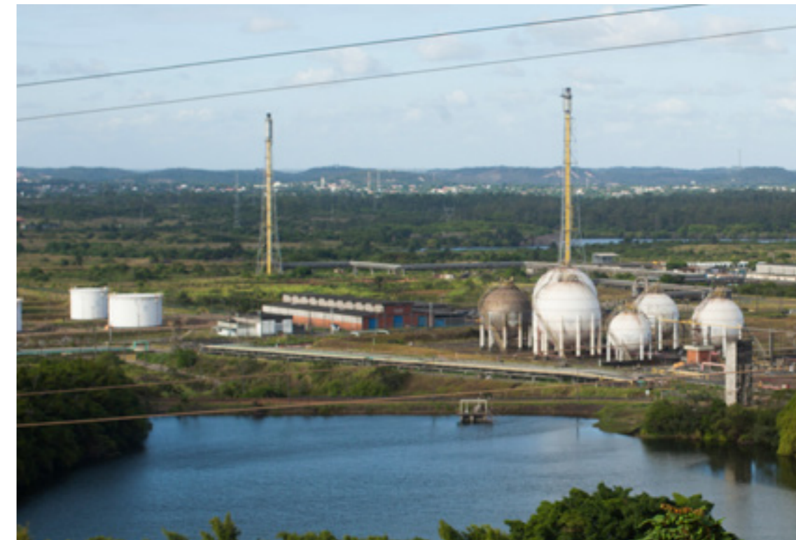
Reaproveitamento de água na Unib 1, a principal planta industrial da Braskem no Polo de Camaçari
