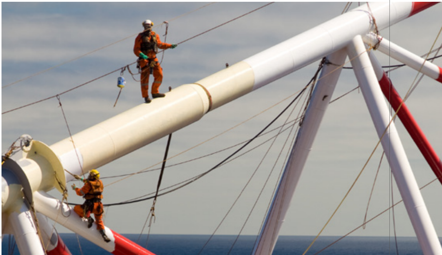
Integrantes da Odebrecht Óleo e Gás, com equipamentos de proteção, fazem reparos em estrutura offshore
