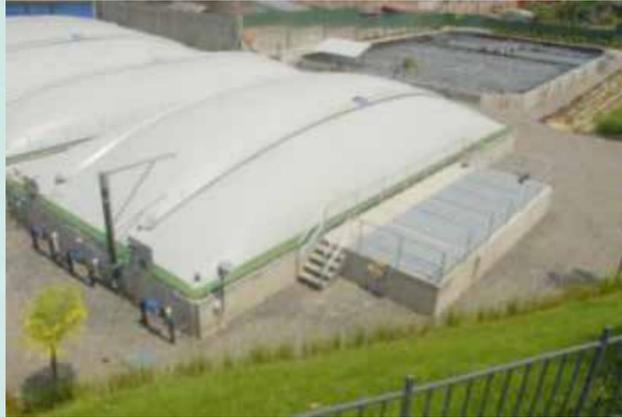
**El uso de fuentes de energía amigables al medio ambiente** es una de los enfoques de la compañía y en este rubro la planta de cerveza a partir del tratamiento de aguas residuales genera biogás que luego es usado como combustible para la alimentación de las calderas de vapor.
