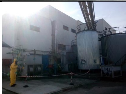
Opération de montage et d'installation d'un nouveau réservoir d'ammoniac
