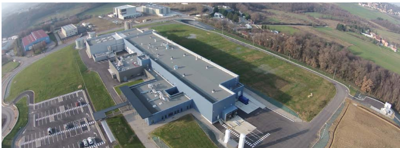
Nueva planta de Communay (Francia)
