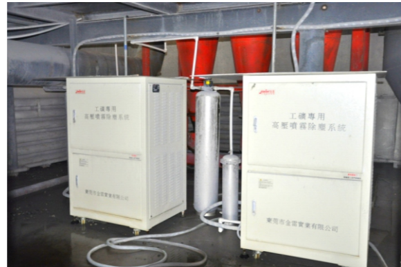
山东鑫泰公司选矿厂除尘系统改造
