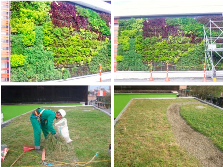
Mantenimientos muro y techo verde
