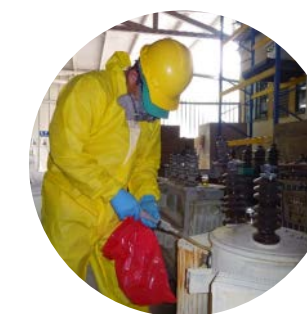
Toma de muestras PCB en piso 2015
