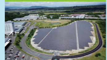
“大福滋贺超大规模太阳能发电系统” 最大发电能力达4,438kW,年发电量为430万度
