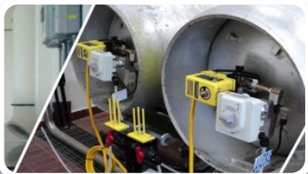
Inyección Química y desinfección
