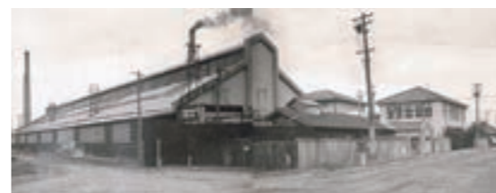
四日市の工場
