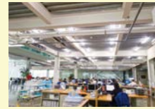
交換したLED照明
