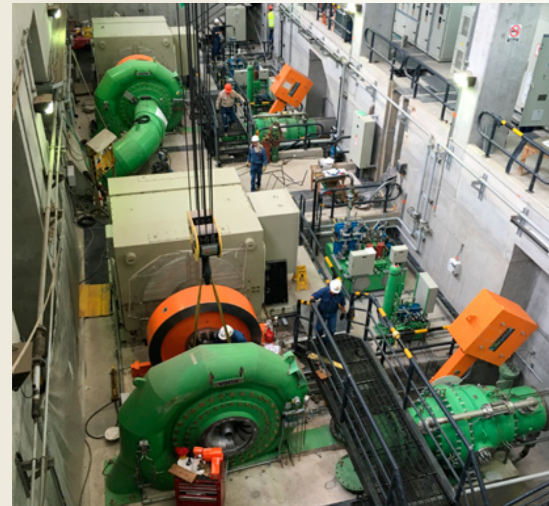
Montaje de equipos – Casa de Máquinas PCH Tunjita
