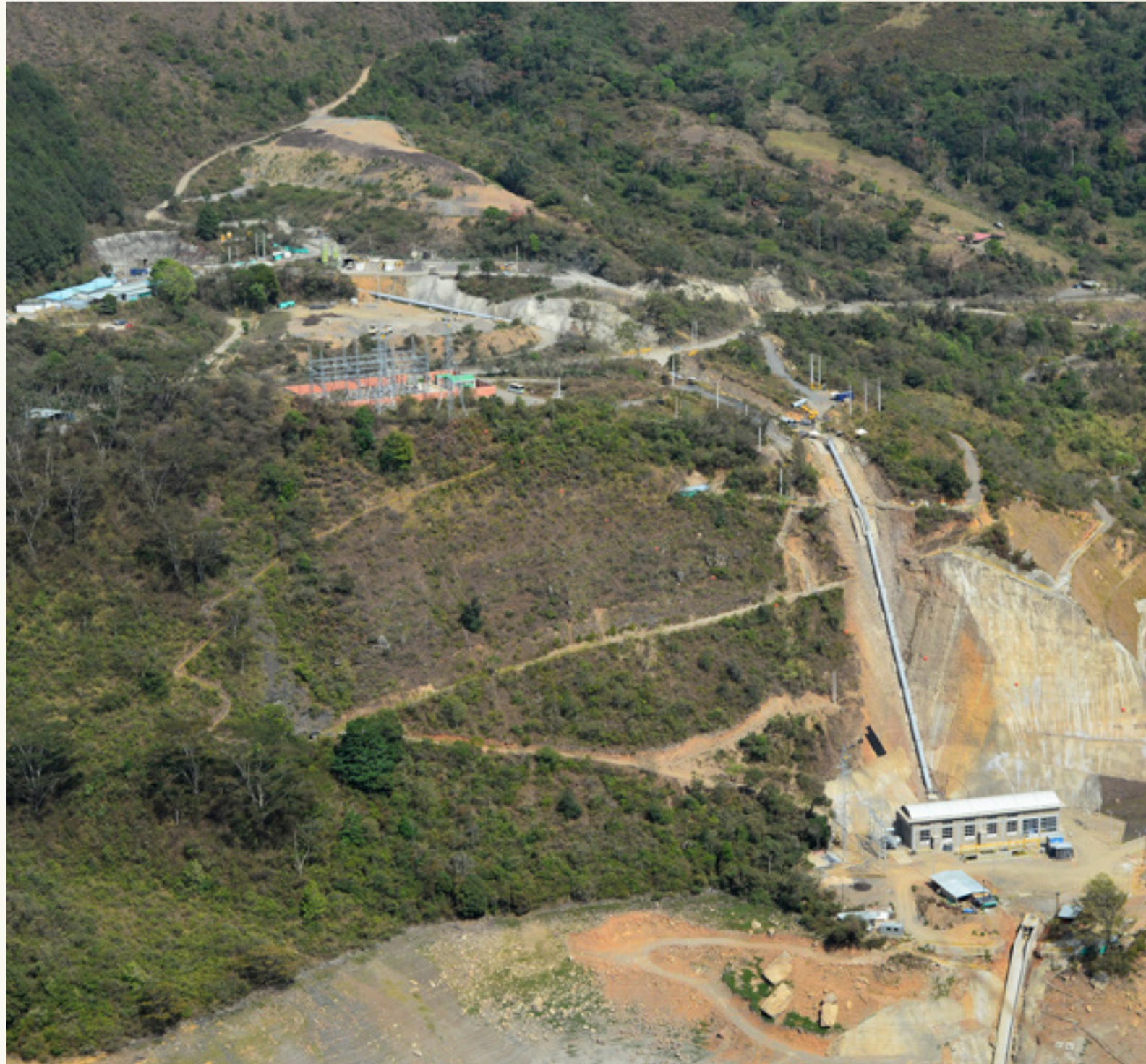
Panorámica del Proyecto por el frente de la Casa de Máquinas y Tubería de Carga.
