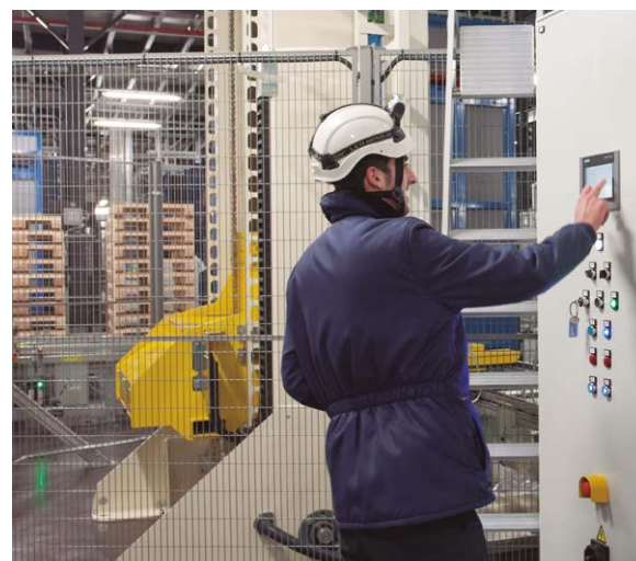
Raúl, trabajador del almacén de refrigerado del bloque logístico de Abrera, Barcelona.
