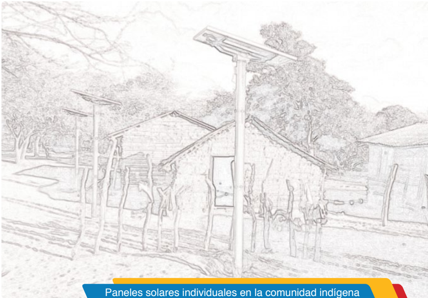
Paneles solares individuales en la comunidad indígena de Malirrachón, municipio de Manaure, Guajira.
