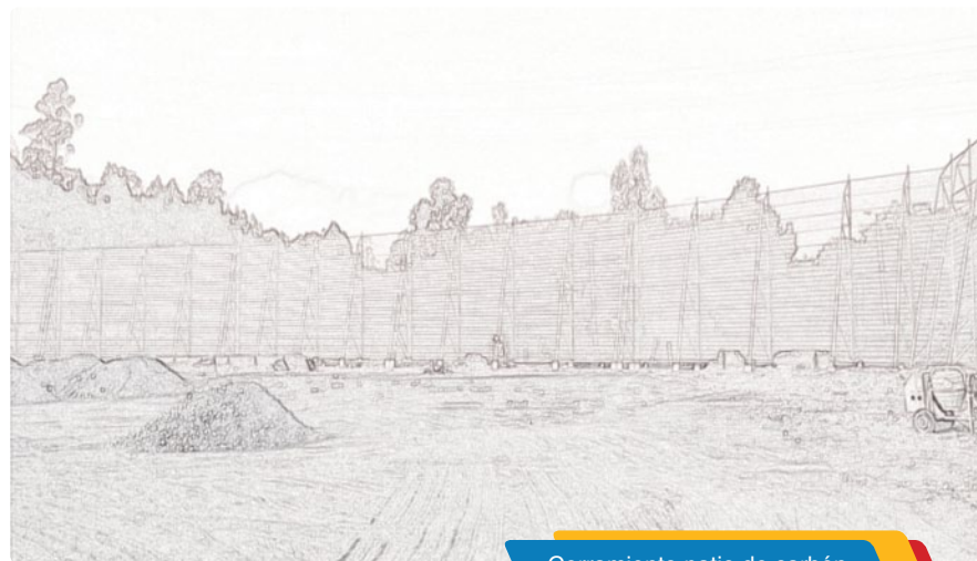
Cerramiento patio de carbón
