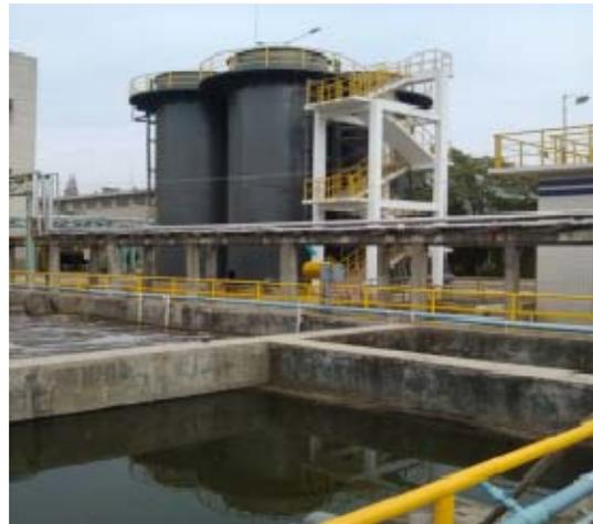
**废气治理方面：**公司各车间工艺废气处理设施运行正常，持续达标排放。生产过程中产生的废气采用水洗、碱洗二级吸收处理工艺，部分反应设施上也配备有尾气预处理装置，生产废气经预处理后再进入集中处理设施。部分干燥设备末端安装有废气冷凝回收装置，能够有效的对挥发性有机物进行冷凝回收。2015年公司还对废水处理系统除油过滤池、预混池和厌氧池进行了加盖封闭，减少废气的逸散。
