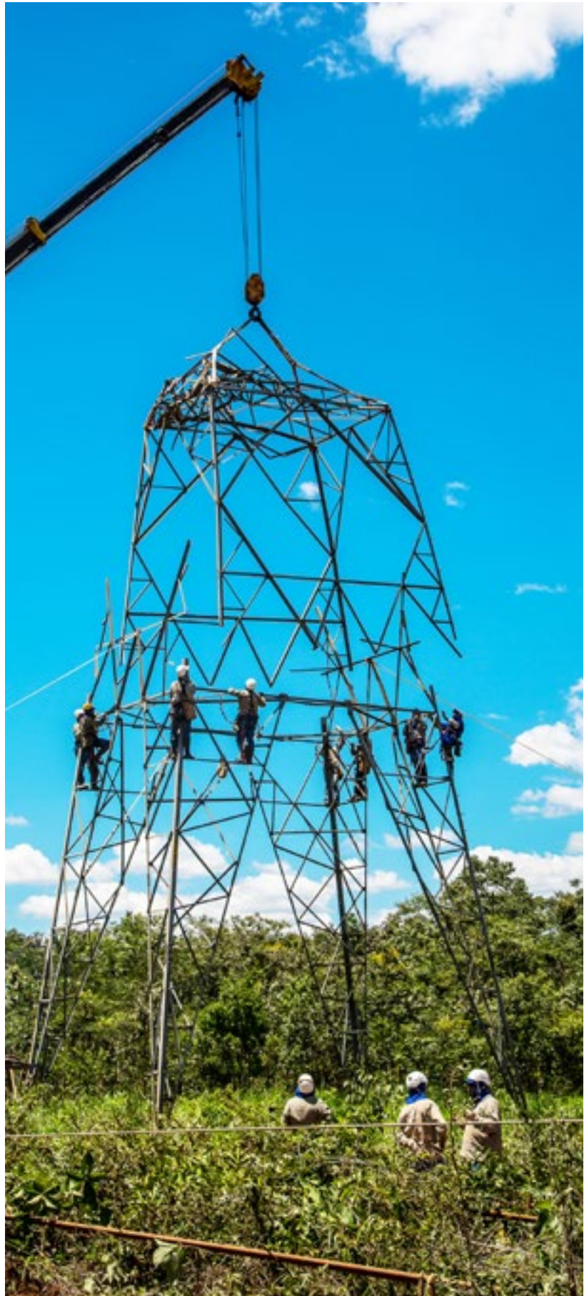
Recuperación de Torres - LT Itumbiara-Porto Colômbia (MG)
