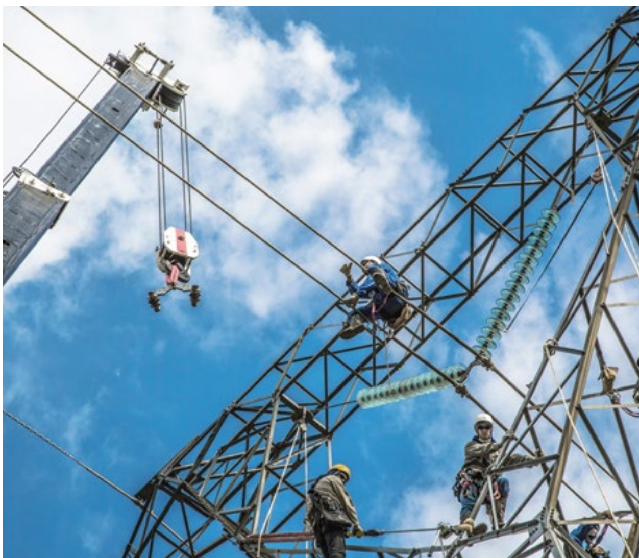
Recuperación de Torres - LT Itumbiara-Rio Verde 2 (GO)
