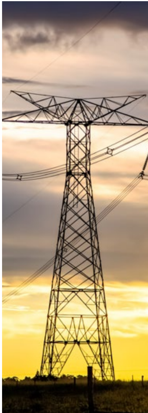
Recuperación de Torres - LT Foz Iguaçu-Ibiúna (PR/SP)
