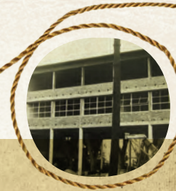
Construção na Aldeia Franciscana
