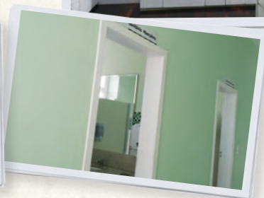
Construção de dois novos banheiros no 1.º andar do prédio
