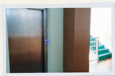
Novo elevador e nova escada para acesso à biblioteca
