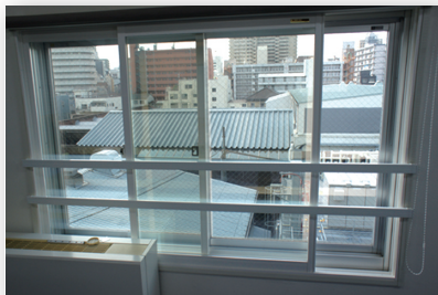
二重窓の設置(本社)
