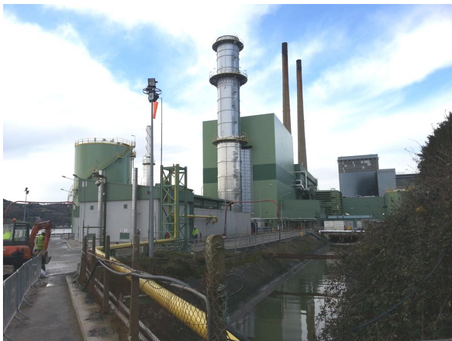
Figura 2. Central eléctrica de Great Island construida por INITEC Energía
