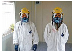
保護具を着用した現地作業員
