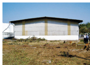
石綿スレート板 除去前の倉庫
