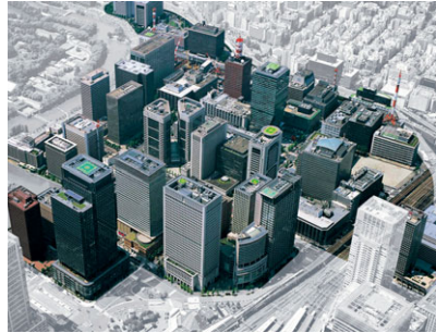
大手町地区・丸の内一丁目地区他・地域冷暖房 (東京都千代田区)
