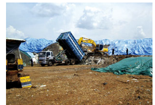
石綿スレート板を廃棄物処理場に埋め立て処分
