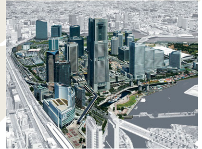
みなとみらい21中央地区・地域冷暖房 (神奈川県横浜市)
