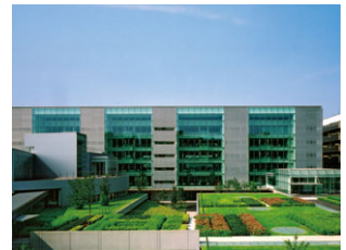
本田技研工業株式会社和光ビル (埼玉県和光市)
