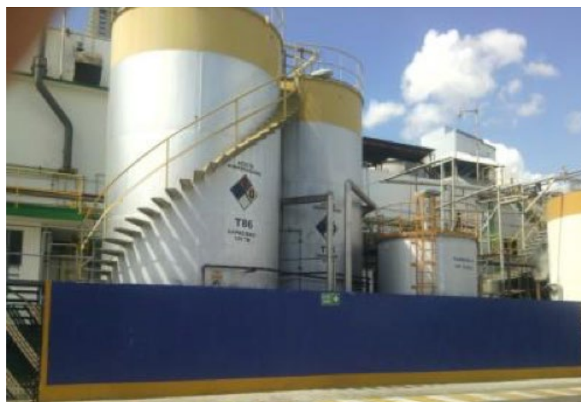
Muros de contención SIDPort
