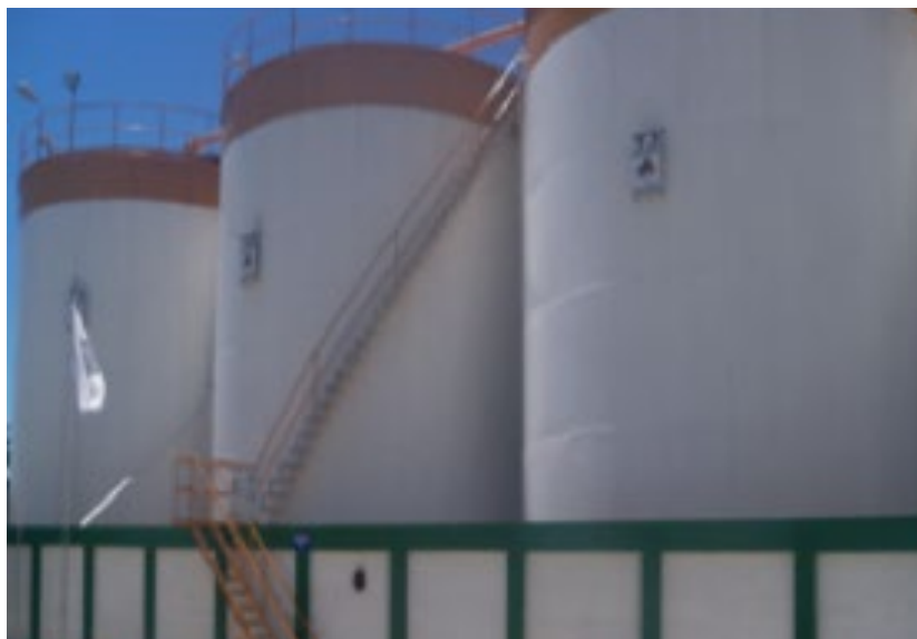
Muros de contención SIDPort
