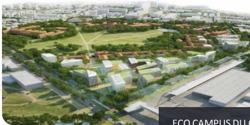
ECO CAMPUS DU GRAND PARIS, à VITRY SUR SEINE (complexité BEPOS), HQE, LABEL EFFINERGIE + , Architectes GROUPE PERIPHERIQUES
