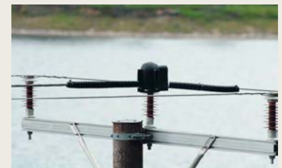
Med to meter vingespenn er risikoen stor for at vingene til hubroen berører to linjer samtidig. De seks piggisolatorene er blitt til tre, og midtfasen er isolert.
