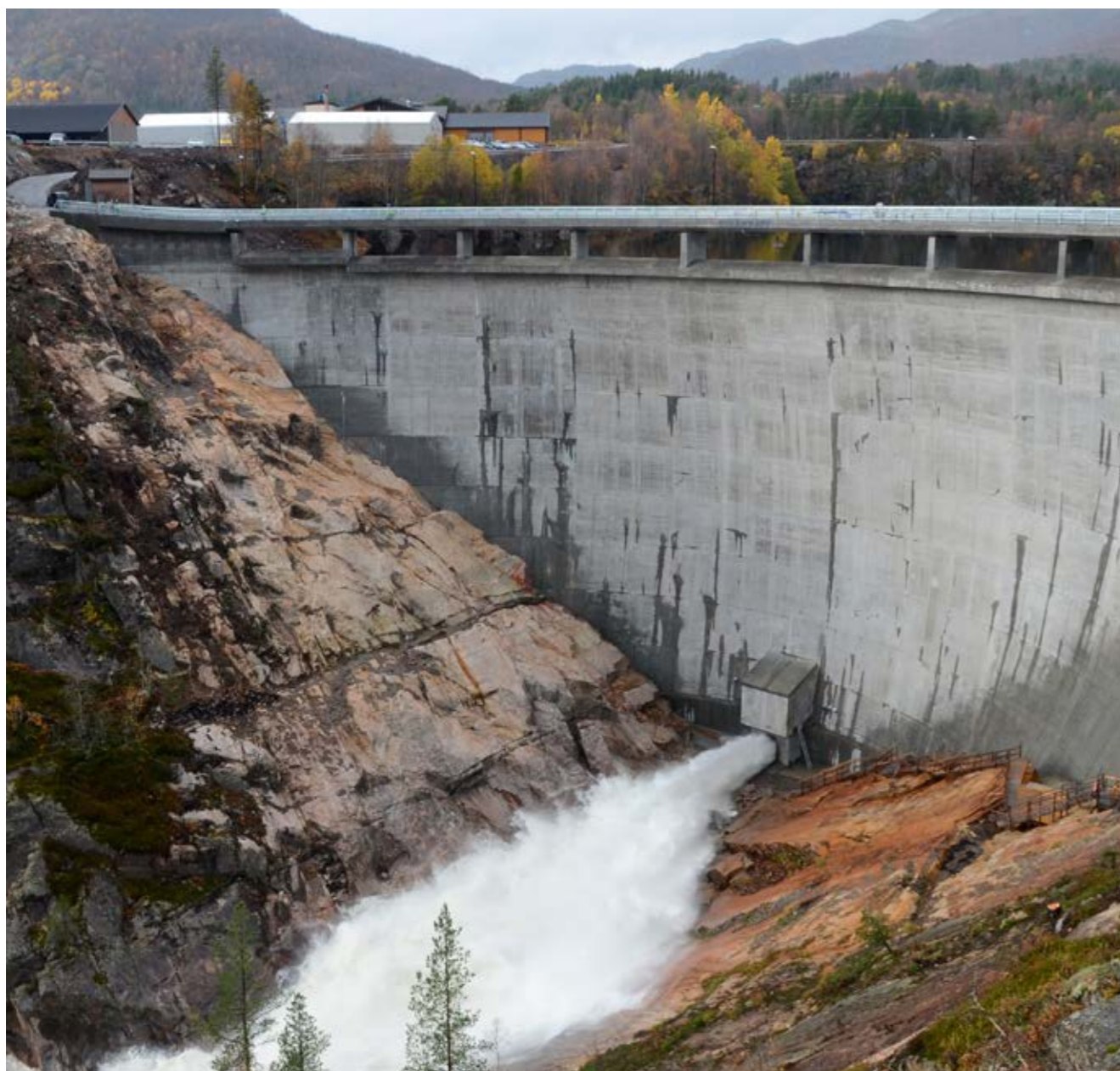
Brøkke Nord og Sør, Skarg kraftverk åpnet i oktober 2014. Prosjektet vil gi økt kraftproduksjon med 175 GWh, tilsvarende strømforbruket til 9 000 husstander.
