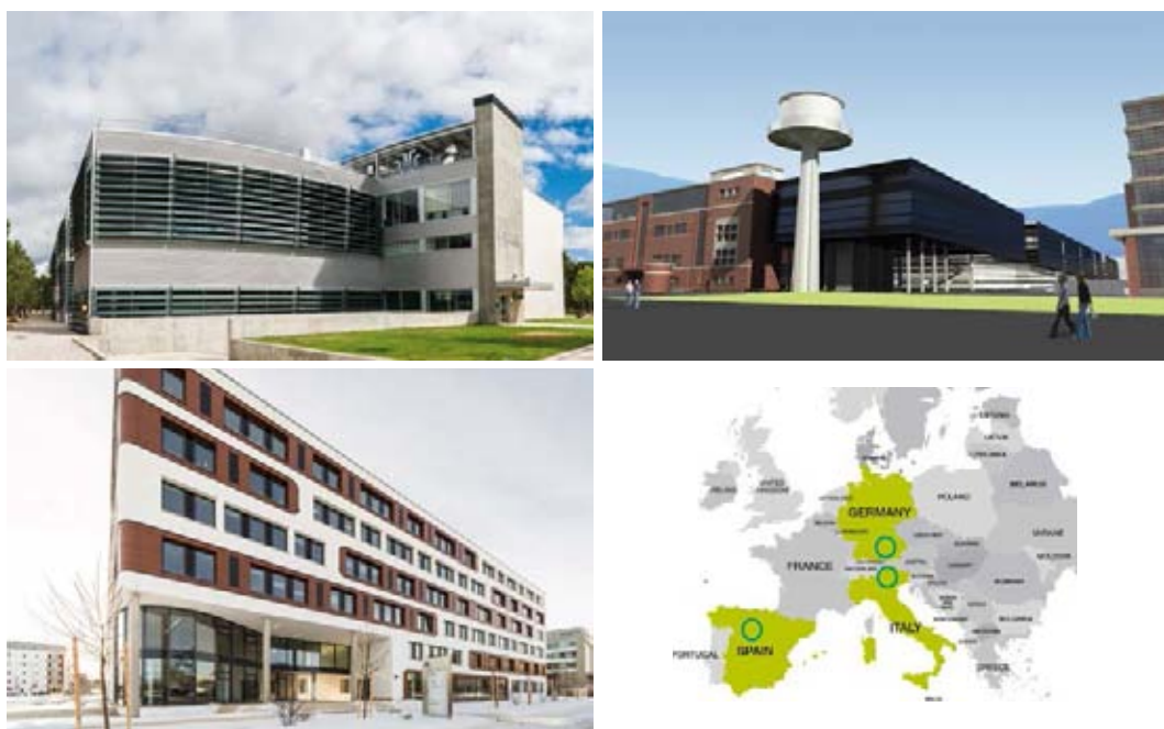
Representación y localización de los tres edificios piloto del proyecto DIRECTION.
