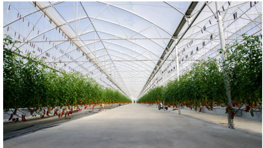
Nuevo invernadero del Grupo para con el sistema de ahorro de agua NGS
